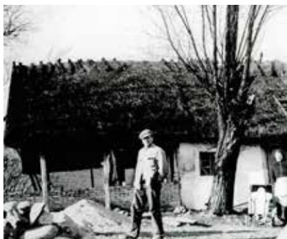
Bindingsværk udskiftes med mursten. Jernløse Lokalhistoriske Arkiv, datering: 1920-30.
