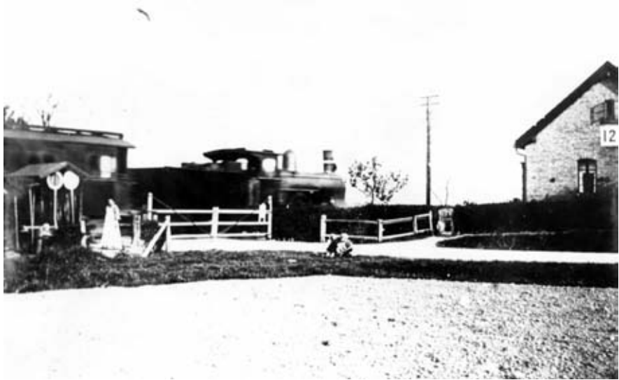
Jernbaneoverskæringen i Skimmede med banehus nr. 12 til h. Datering: 1911.
